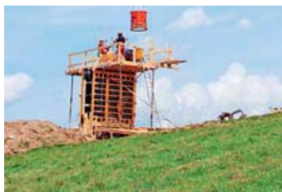
2 Sécuriser les zones à risque de chute.
