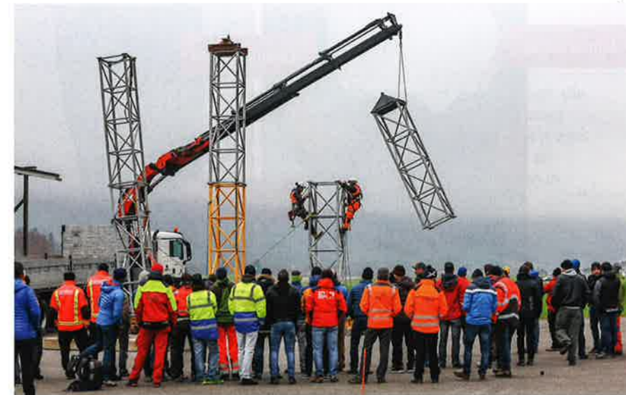
Alternativ zum geplanten Helikoptereinsatz wurden die praktischen Montagen mit einem Kran durchgeführt.
